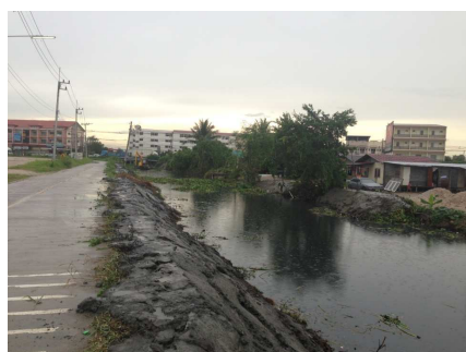
คลองตาเกตุที่อยู่ภายนอกนิคมฯ
